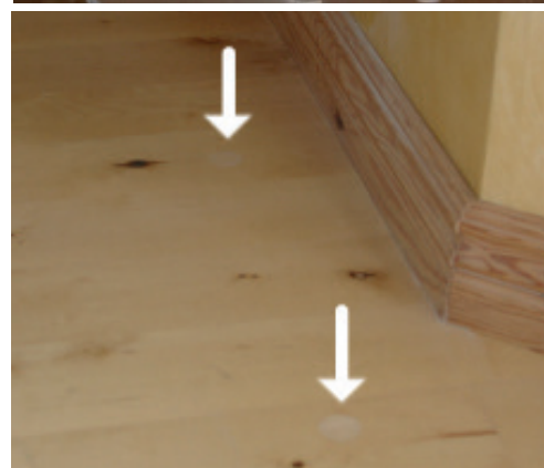
Vi borrar hål på 25 mm, sprutar in isoleringen och sätter igen hålet med anpassade pluggar beroende på golv.
